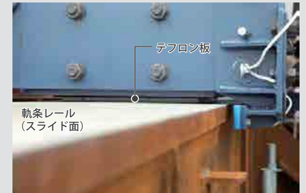
スライドジャッキ底面のテフロン板
