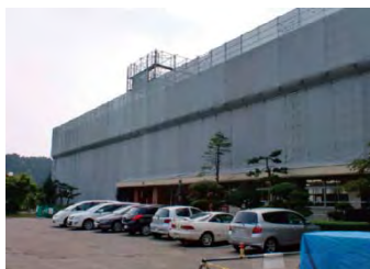
外部足場の全面メッシュシート張り
