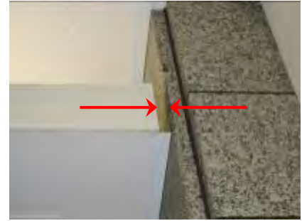
写真: 吊天井の耐震化(周辺壁面とのクリアランス確保)
