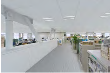
写真:執務室内における制振装置の設置イメージ
