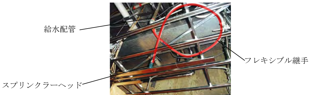
写真: スプリンクラー配管のフレキシブル化
