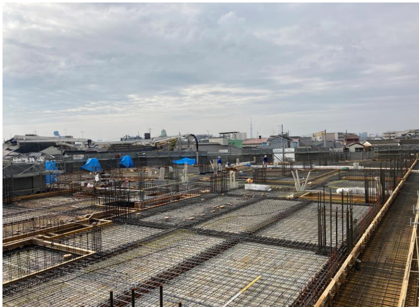
敷地北西側 足場上より
