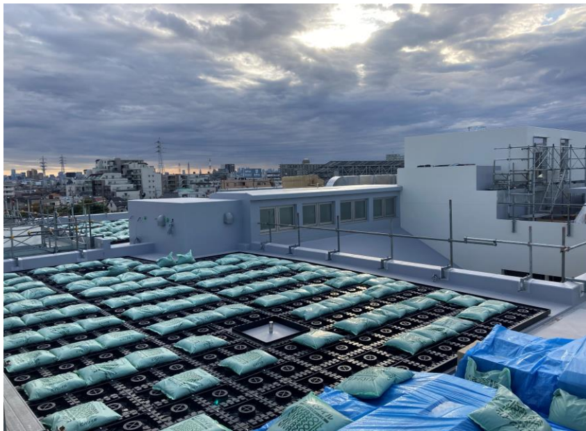
敷地北西側 足場上より
