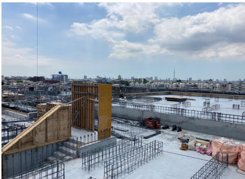
敷地北西側 足場上より
