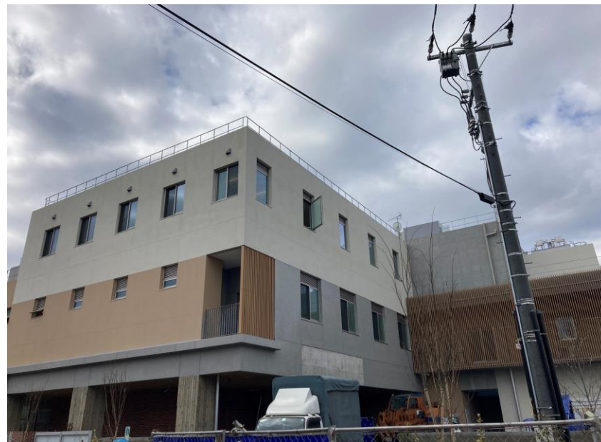
敷地北東側 エントランス付近
