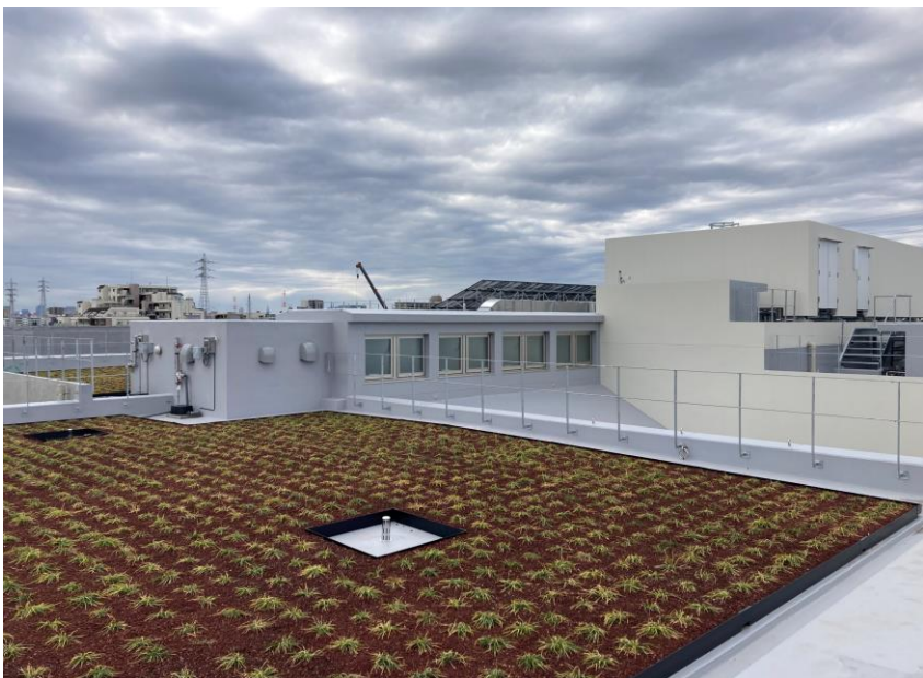
敷地北西側 屋上
