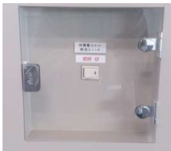
写真 11.2 待機電力カット系統制御スイッチ
