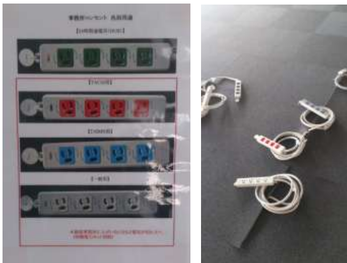
写真 11.1 待機電力カット系統コンセントの色分け(設置事例)
