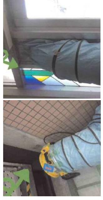
送風機により通気性を確保するとともに、ドライミスト発生装置等も併用
