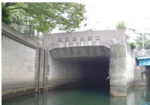
水道橋分水路（神田川）
