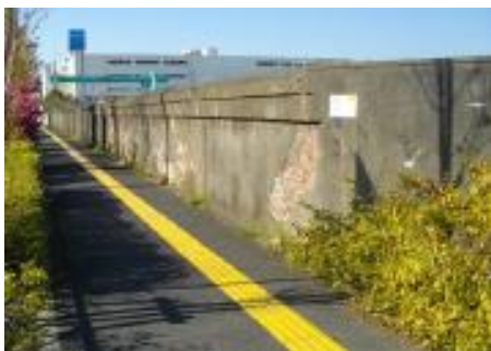
〈墨田5丁目運動場（コンクリート塀）〉
