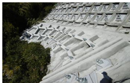
法枠工*・アンカー工*
