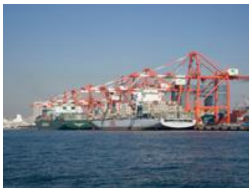
青海ふ頭（係留施設（岸壁））
