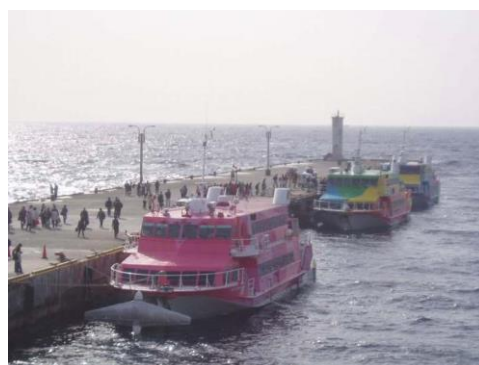
元町港（係留施設（岸壁））
