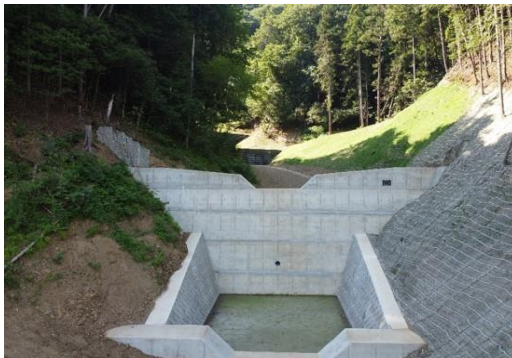
治山施設（谷止工）
