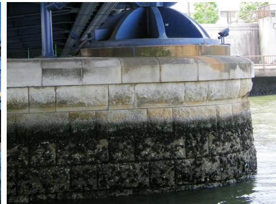
〈清洲橋の橋脚に貼られた御影石〉
