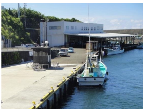
係留施設（岸壁）
