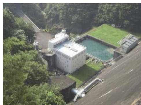
多摩川第一発電所
