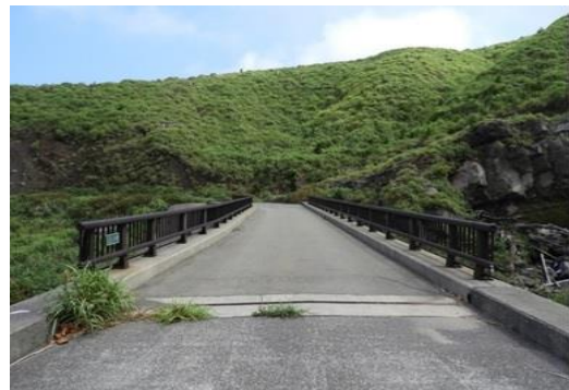
林道施設（橋梁 りょう ）
