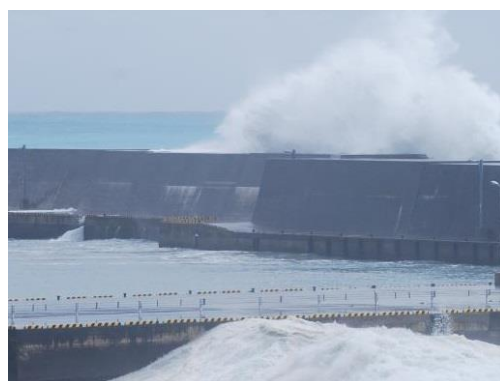
外郭施設*（防波堤）
