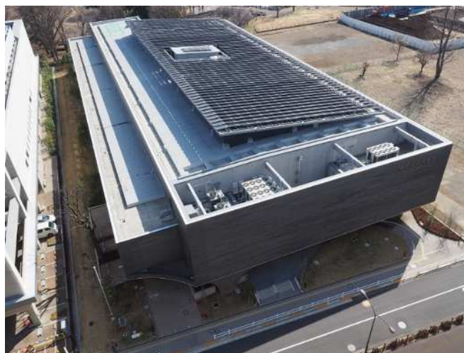
(太陽光発電設備)
