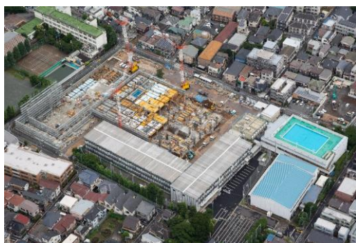
4 令和2年 7月 工事工程：躯体工事中
