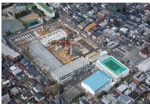
4 令和2年 4月 工事工程：杭工事中
