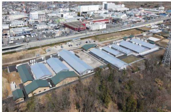
改築工事後の施設（全景）
