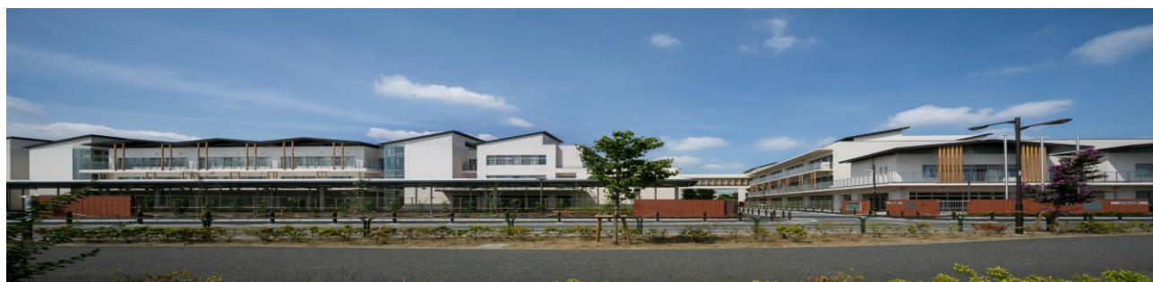
東側より校舎を臨む（改築工事後）
