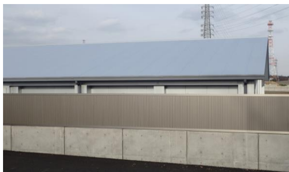
フェンスの設置
