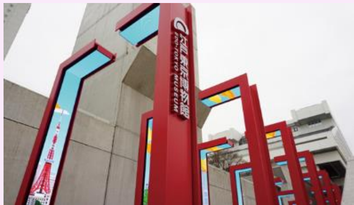
< 1階西側アプローチ >
