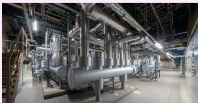
＜館内の設備機器の改修＞
