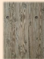
＜ 材型枠コンクリート ＞
