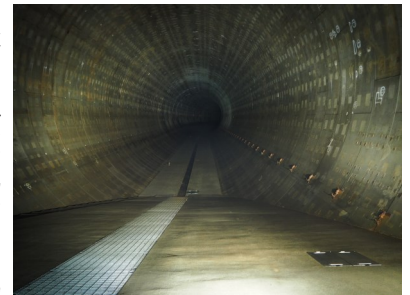
＜地下調節池内部＞
