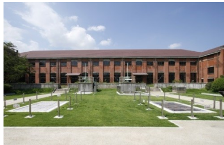
【旧三河島污水処分場唧筒場（ポンプじょう）施設】
