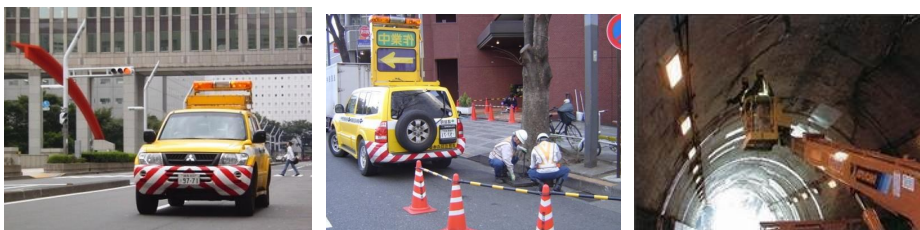
<日常的な巡回点検>
