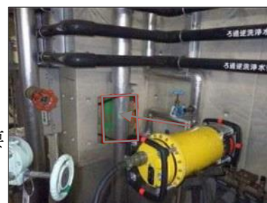
図9 体育館の空調ドレン管の撮影状況
