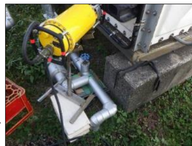
図6 保育園の給水管の撮影状況
