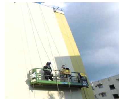
【可搬型ゴンドラによる全面打診状況】
