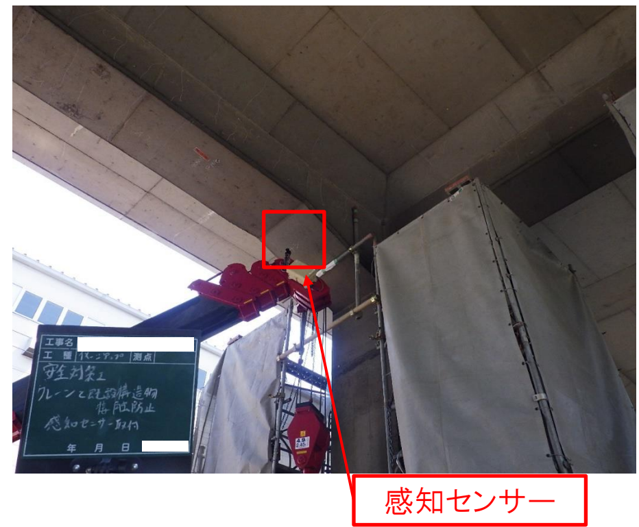
【クレーン作業状況】
