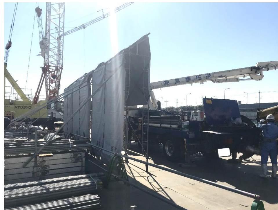
コンクリート打設時はポンプ車のホッパー部横に設置
