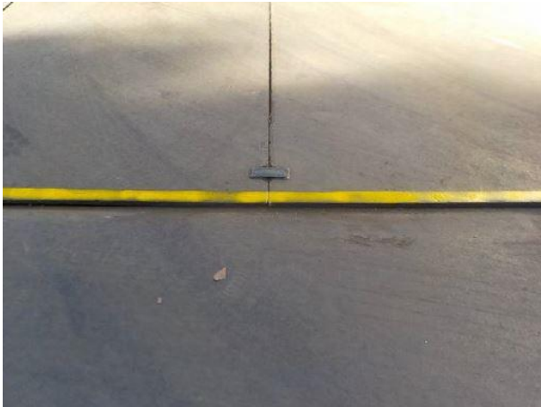
【鉄板段差部のマーキング】
