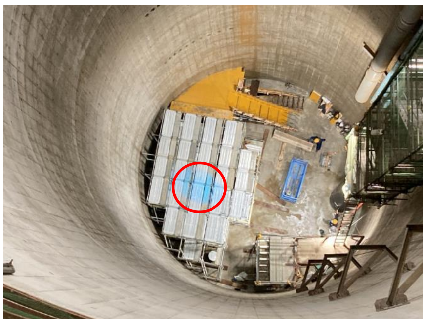
【立坑下荷卸し場所明示】
