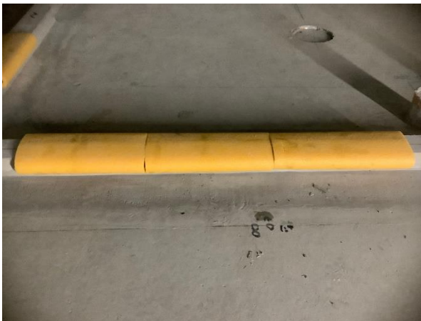
【躯体段差部の明示】
