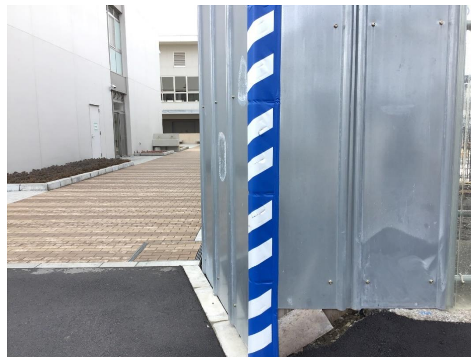
【仮囲いコーナーに保護クッションを設置】
