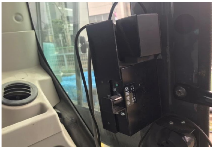
オペレーター室の警報装置
