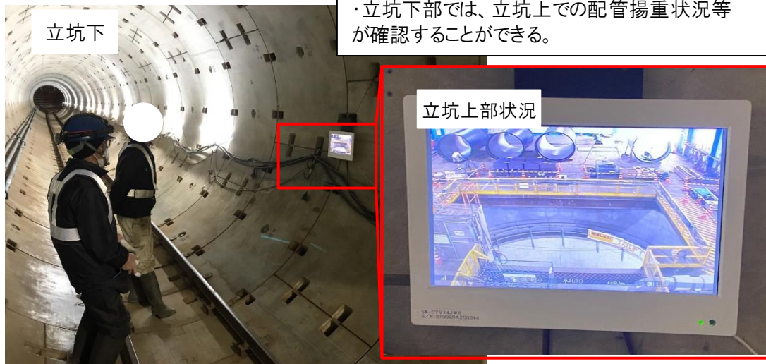
【立坑上・下でのモニターの設置状況】
