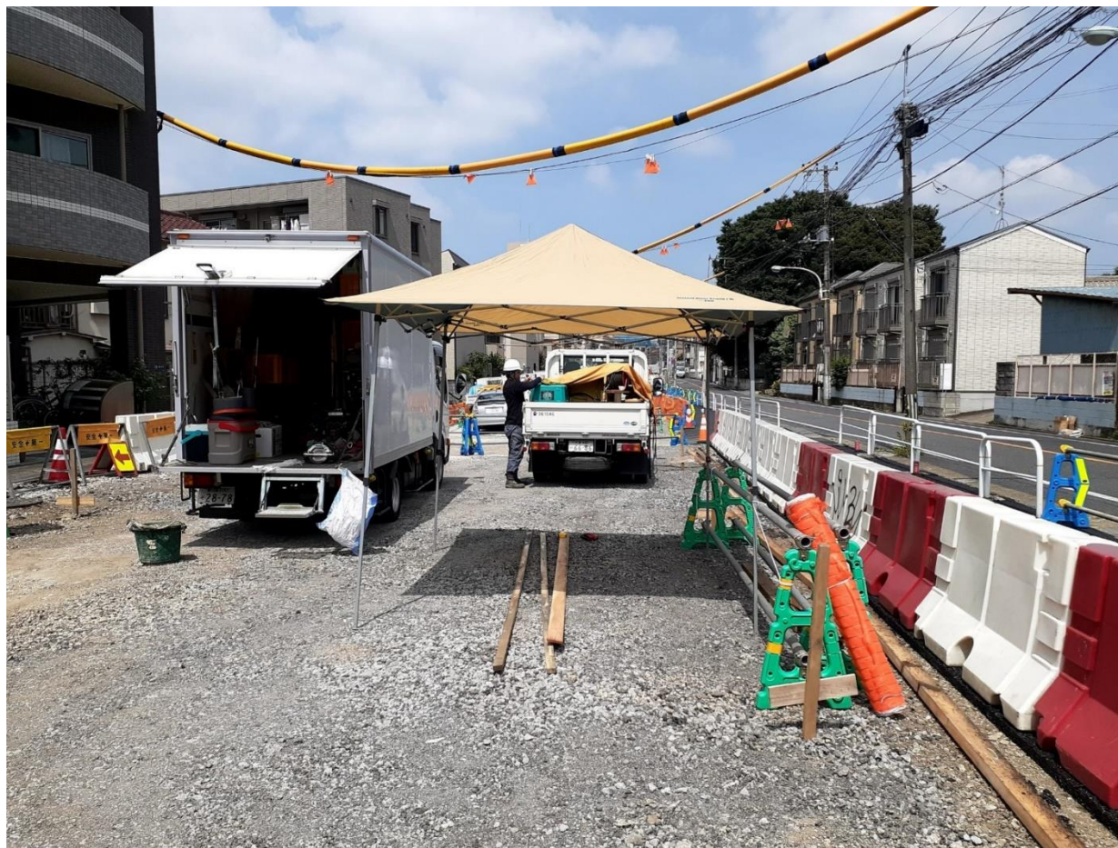
【仮設テント設置状況】
