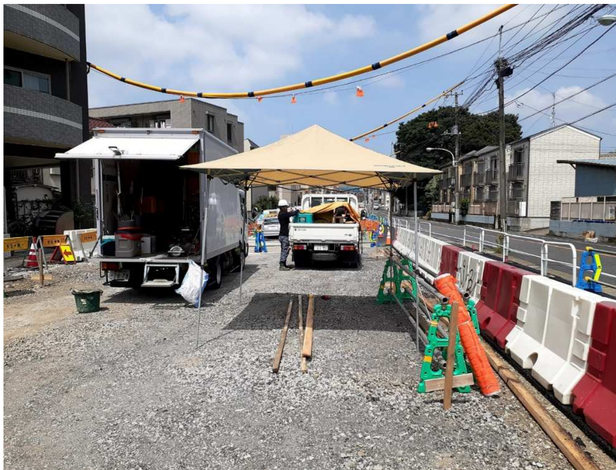
【仮設テント設置状況】
