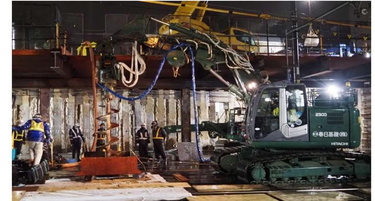
土留杭設置イメージ (軌道仮受杭施工時)
