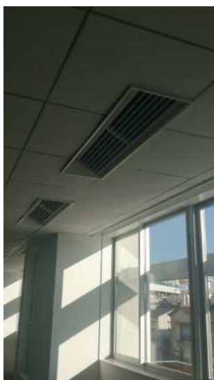
写真 3.1 東京都事務所自然換気システム設置事例 (自然換気取入口(左)、排出口(中央)、排出口:階段室上部換気窓(右))
