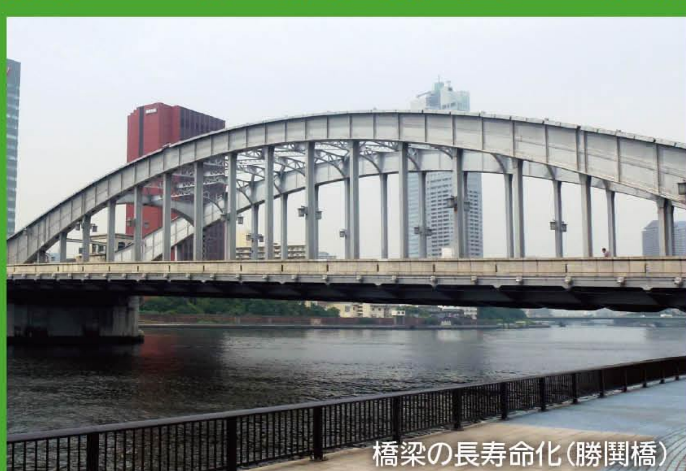
橋梁の長寿化(勝間橋)
