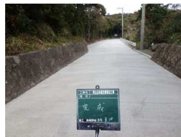
施工後（路面工等）
