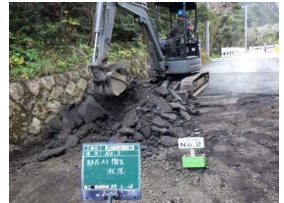
構造物撤去工（アスファルト舗装撤去）
