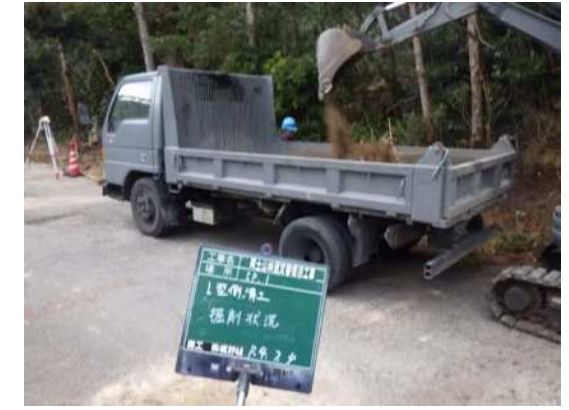
土工（掘削積込）
