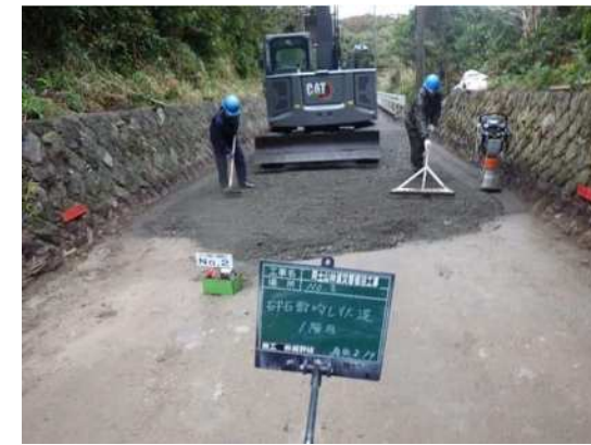
路面工（砕石敷均し）
