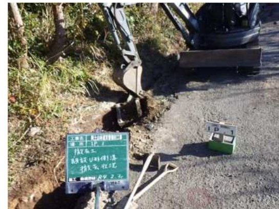
構造物撤去工（U型側溝撤去）
