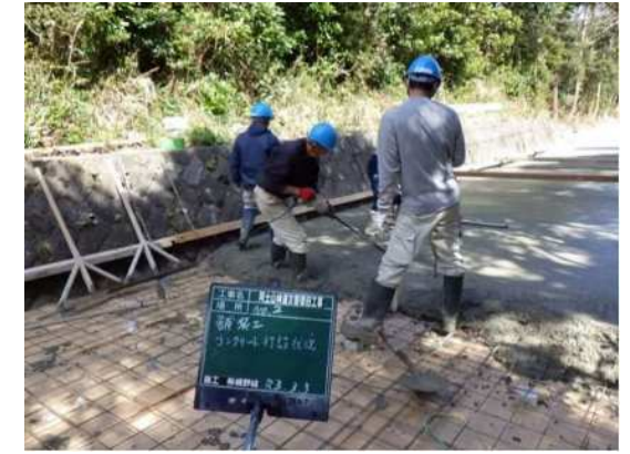
路面工（コンクリート打設）
