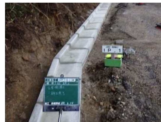
L型側溝工
