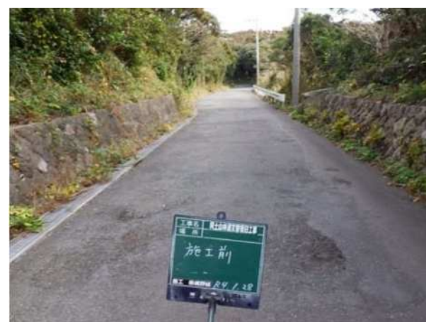
施工前（路面工等）
