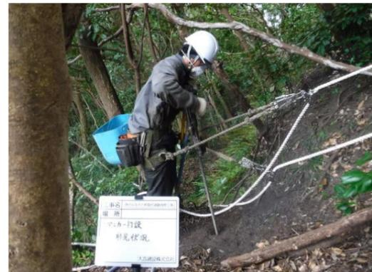
覆式落石防護網（アンカー打込作業）
