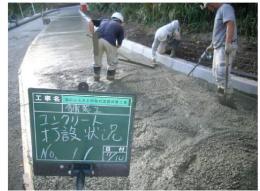
コンクリート舗装（コンクリート打設作業）
