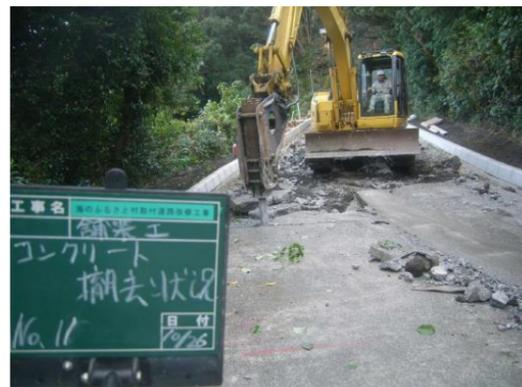
構造物取り壊し（舗装版撤去）
