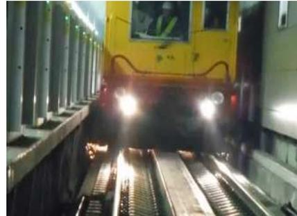
写真-削正作業中
