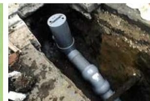
図-3 ます・取付管設置状況
