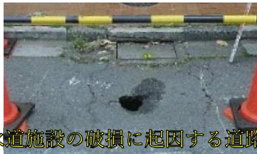
下水道施設の破損に起因する道路陥没
