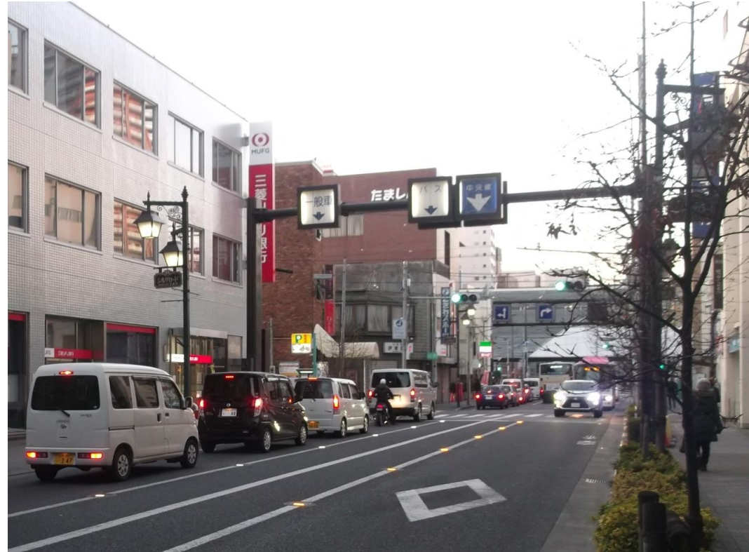
(「本町5丁目交差点」手前(北側)から武蔵小金井駅方向を撮影。 左側2車線が南行き車線、右側1車線が北行き車線)
