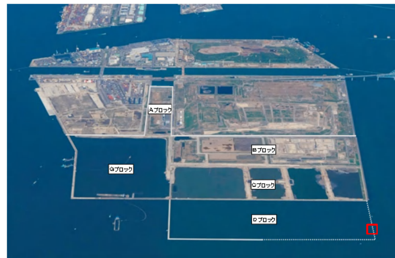
新海面処分場(全景)
