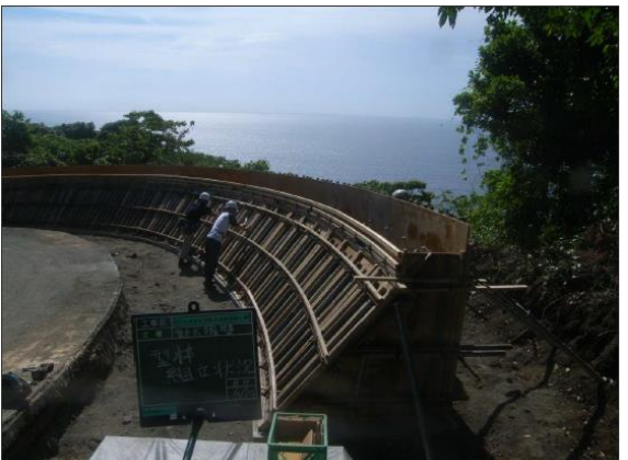
重力式擁壁工（型枠組立作業）
