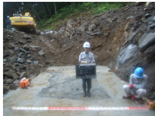
床付け（均しコンクリート）完了状況
