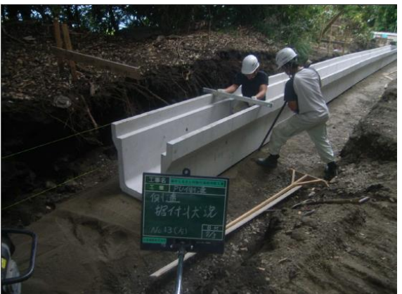
側溝工（据付作業）
