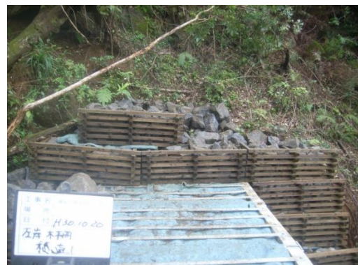
木製間詰め施工完了状況
