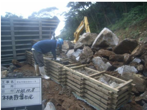
木製間詰め設置状況
