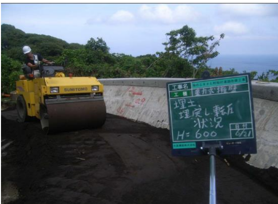
重力式擁壁工（埋戻転圧作業）
