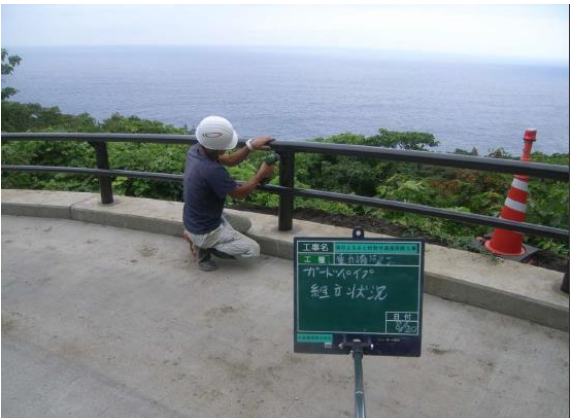
路側防護柵工（組立作業）
