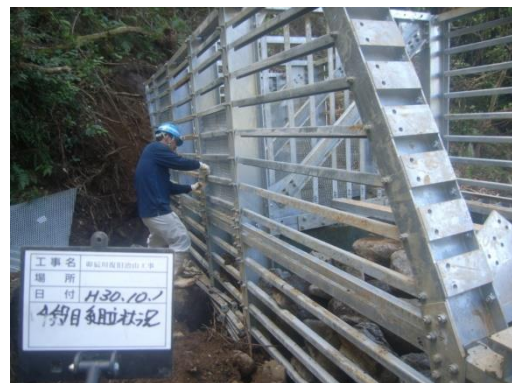
鋼製枠組立状況
