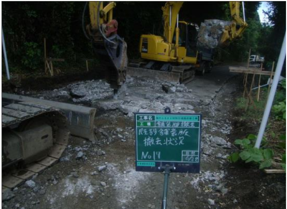
構造物取り壊し（舗装版撤去）
