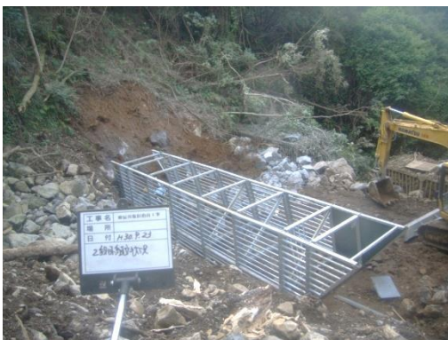
鋼製枠組立状況
