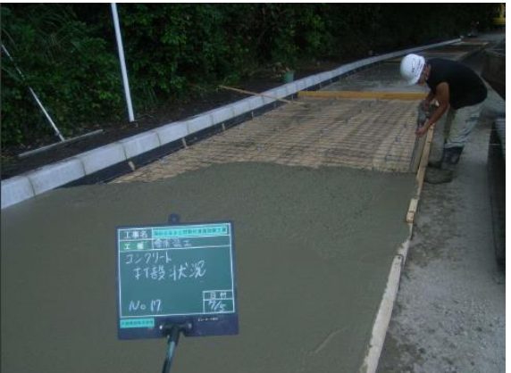
コンクリート舗装工 （コンクリート打設作業）
