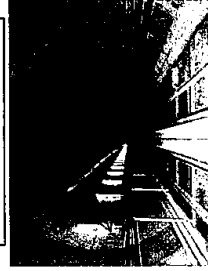
シールドトンネル内(例)
