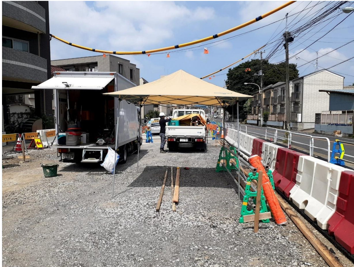
【仮設テント設置状況】
