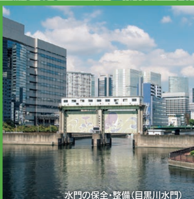
水門の保全・整備(目黒川水門)
