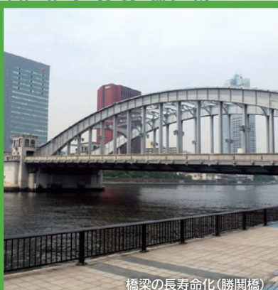
橋梁の長寿命化(勝鬨橋)
