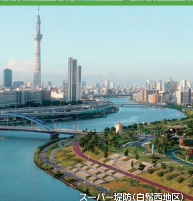
スーパー堤防(白鷺西地区)
