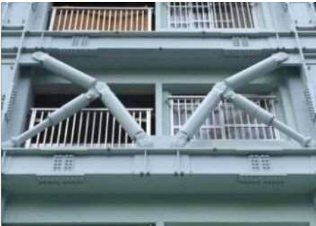
上階：制震ブレース工法による補強
