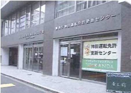
神田庁舎玄関周辺(改修前)
