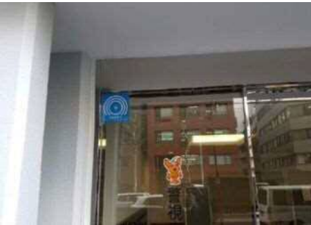
耐震シール貼付状況
