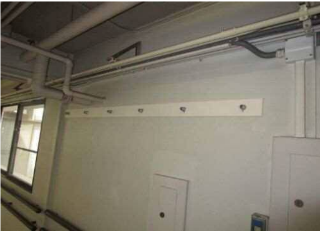
CB 壁補強部分（事務室廊下）
