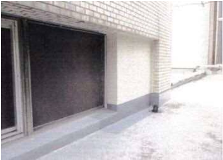
RC 袖壁補強（事務室外部）
