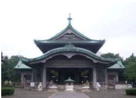
慰霊堂（着工前）
