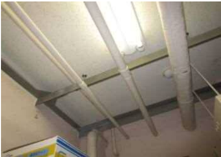
CB 壁補強（倉庫）
