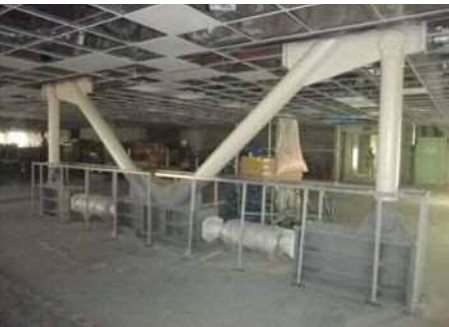
制振装置の施工中
