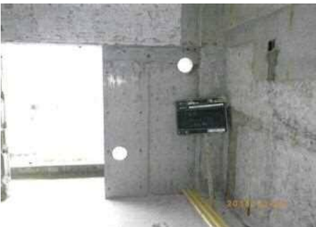
耐震袖壁設置
