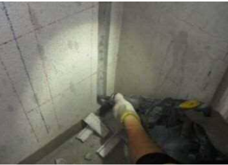
スリットによる補強、工事の様子 (住宅として利用しながらの工事のため、部分スリットを採用)
