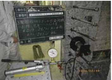
アンカー工事
