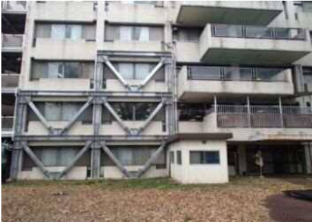
病棟南側（A 病棟）
