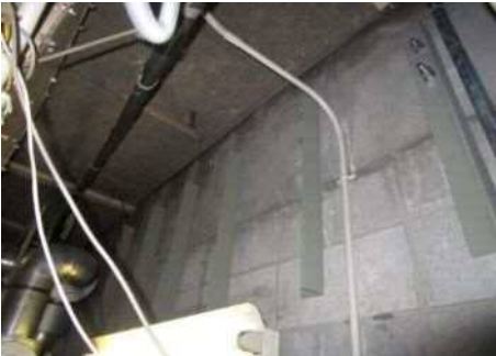
CB 壁補強（空調機械室）
