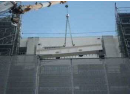
鉄骨ブレースによる補強、工事の様子
