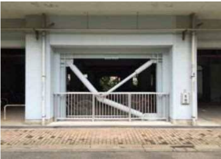
1 階：増し打ち梁、制震ブレース工法による補強
