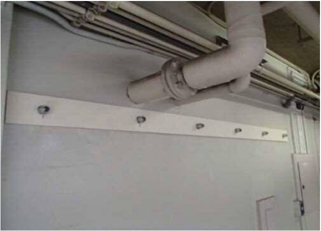
CB 壁補強部分（事務室廊下）
