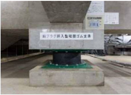
鉛プラグ挿入型積層ゴム支承
