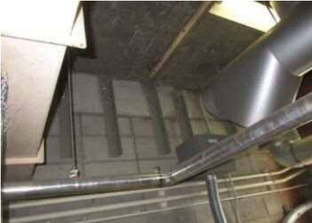
CB 壁補強（空調機械室）
