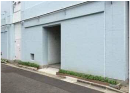
住棟外側の妻壁の増し打ち壁による補強
