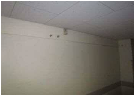
CB 壁補強（EV ホール）
