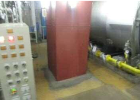
鋼板巻き補強（ボイラー室）
