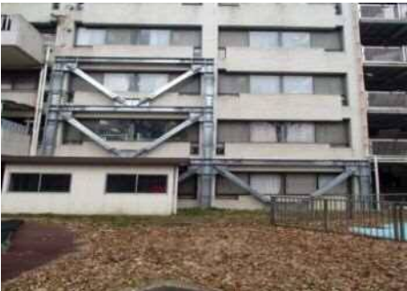
病棟南側（B 病棟）
