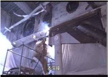
設置場所に溶接する様子
