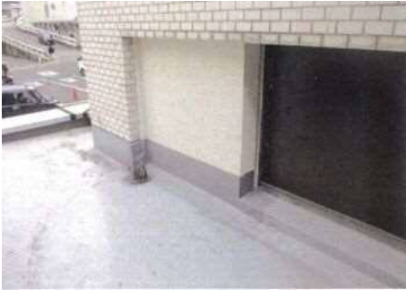
RC 袖壁補強（事務室外部）
