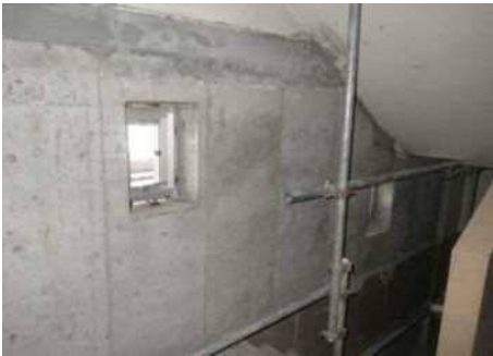
開口閉塞による補強 (階段室のため、採光用の小さな開口を残した。)
