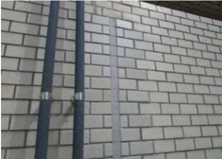
構造スリット（外部）
