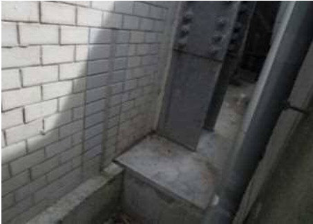
構造スリット（外部）
