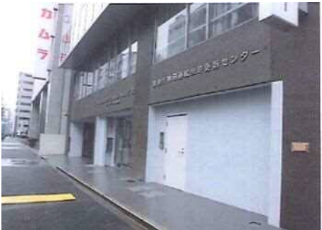
神田庁舎玄関周辺(改修後)
