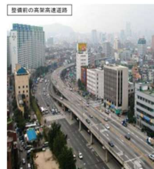
整備前の高架高速道路
