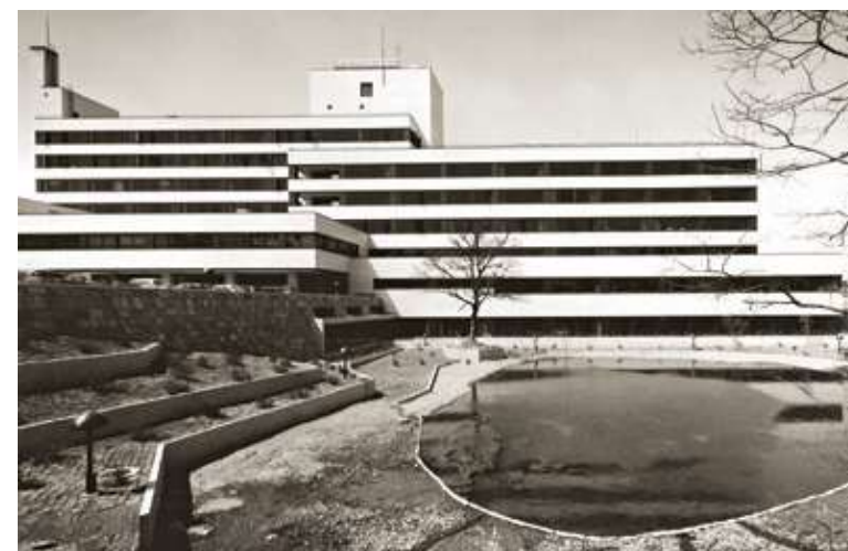
開設当時の青山病院全景
