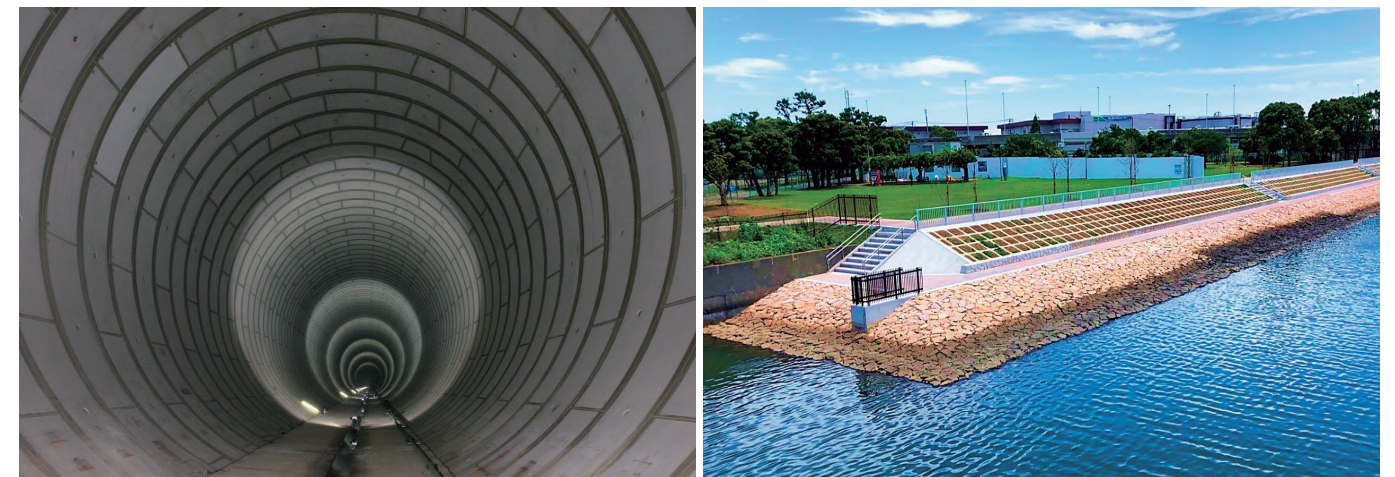
神田川・環状七号線地下調整池
