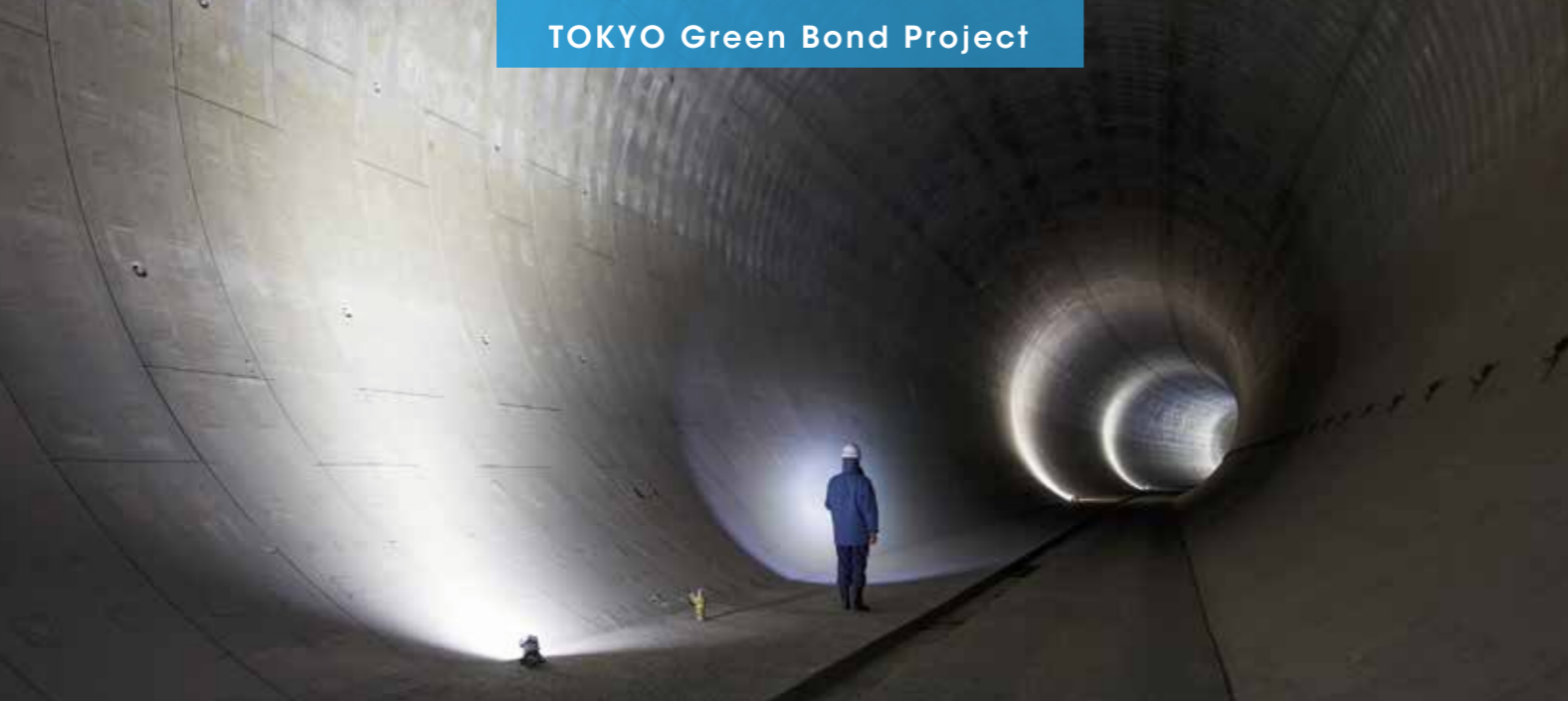
神田川・環状七号線地下調節池 (地下トンネル式)
