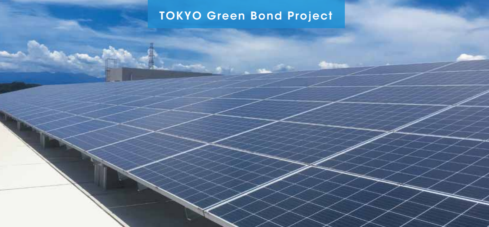
都立永山高等学校 屋上
