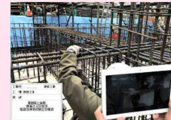
Webカメラを利用した遠隔検査
