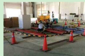
工事エリアの区画を設定して作業
