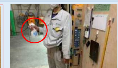
EVの操作盤等の消毒を徹底
