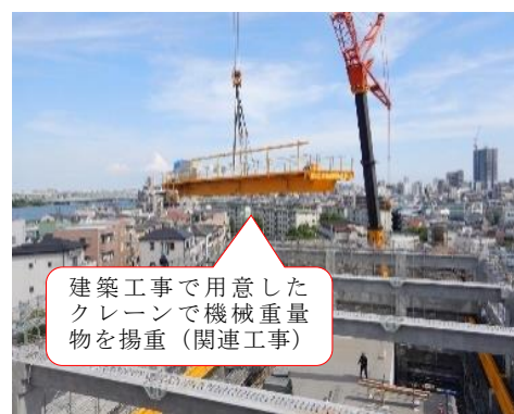
図 14_揚重機の共用
