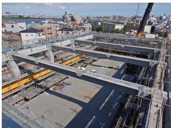
図 11_部材設置状況
