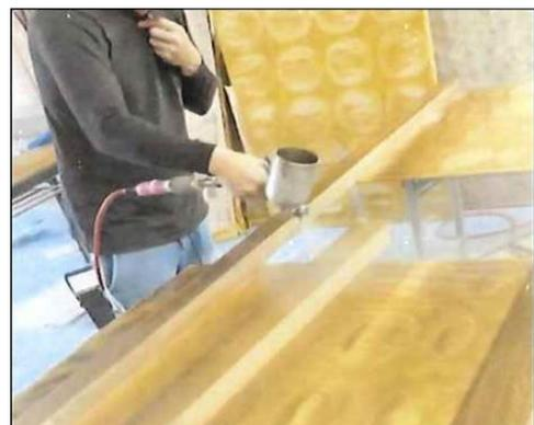
写真4. 液体ガラスの塗装作業
