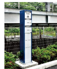
【写真 12】電気自動車充電機
