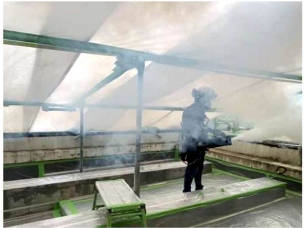
図4：スモークマシンを用いた負圧隔離養生の確認
