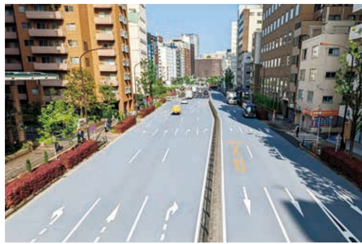
道路の遮熱性・保水性舗装
