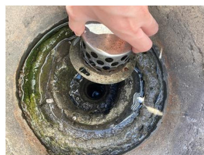
図11 満流型雨水排水システム専用ドレン
