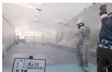
図13 ポリウレア吹付状況
