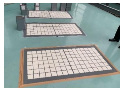
図 18 タイル模様目地幅検討サンプル
