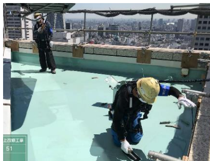
図9 小屋根施工の様子
