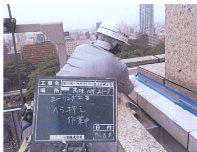
図5 ゴンドラによる施工の様子
