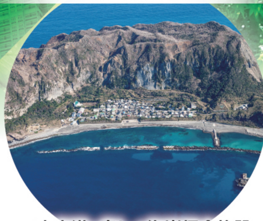
東京港・島しょ海岸保全施設 整備事業
