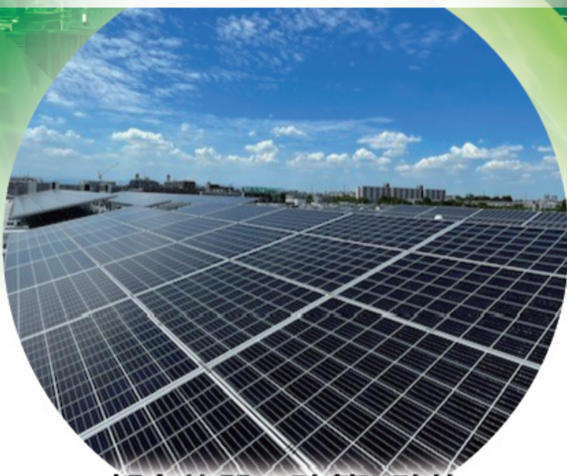
都有施設の改築・改修 (太陽光発電)
