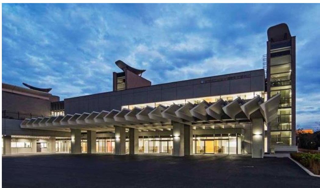
エントランスを望む
