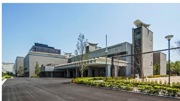
アプローチより校舎を望む
