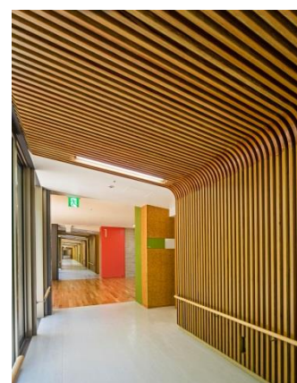
廊下木ルーバー
