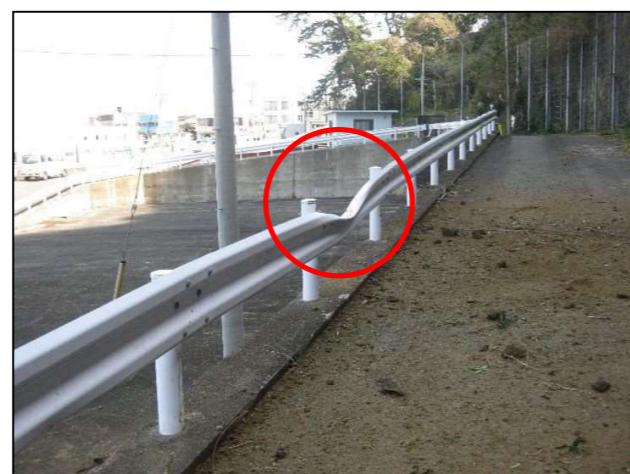
落石に伴う施設破損状況
