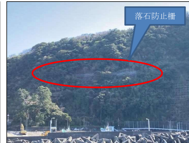
施工後 (落石防止柵)
