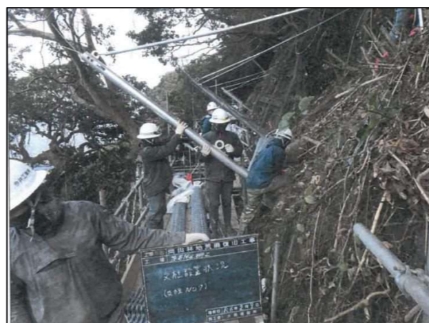
支柱設置 (落石防止柵)
