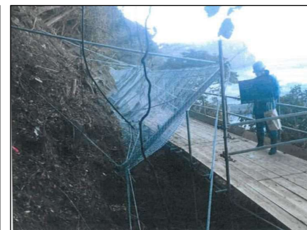
ワイヤー・金網設置 (落石防止柵)
