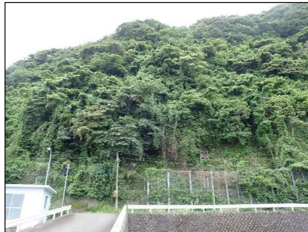
施工前 (落石防止柵)
