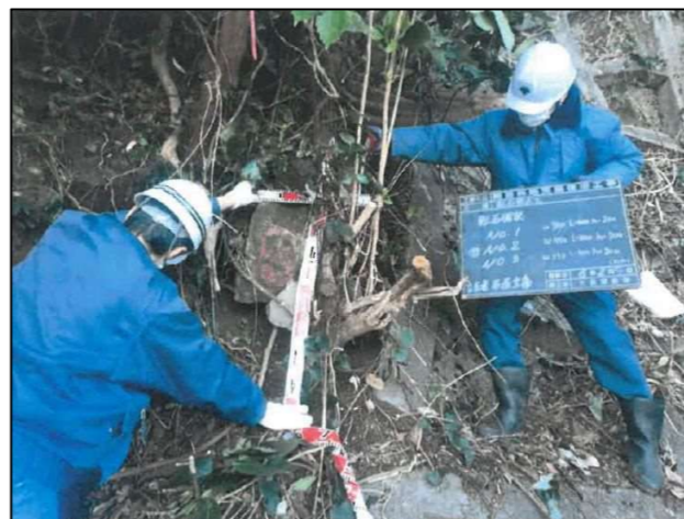
施工前 (転石除去)
