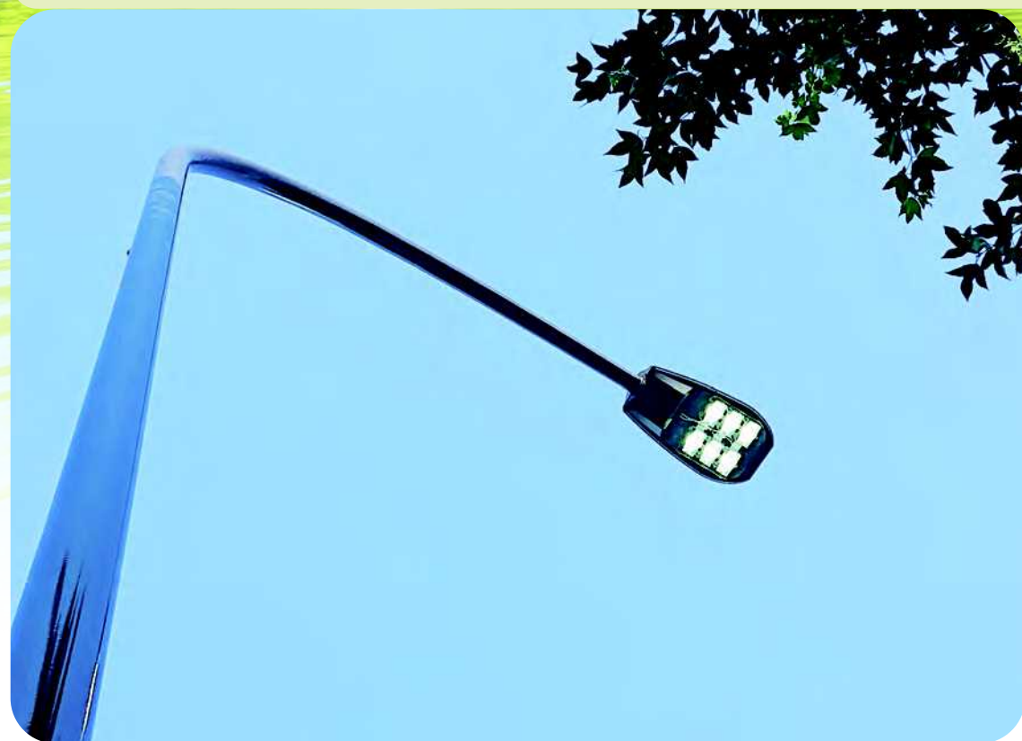
都有施設・道路の照明のLED化
