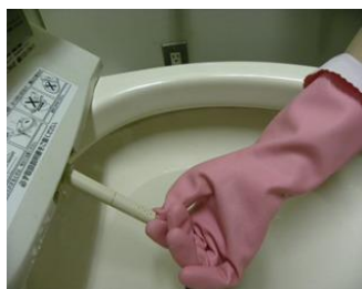
①ゴム手ぶくろ（ピンク）をして、温水洗浄便座のノズルをおさええて引き出す
