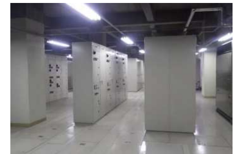
低圧電気設備・特殊電源設備
