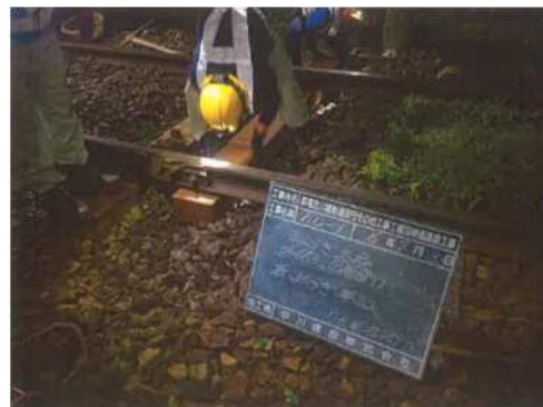
まくらぎ交換工
