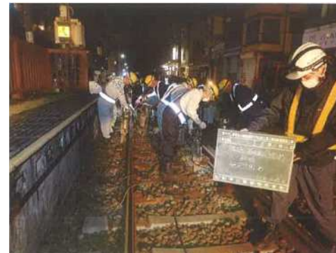
道床総つき固め工
