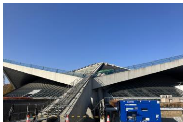
駒沢オリンピック公園 総合運動場【体育館】
