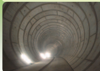
地下調節池の整備
